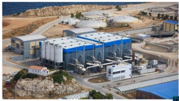
ΚΕΝΤΡΟ ΕΠΕΞΕΡΓΑΣΙΑΣ ΛΥΜΑΤΩΝ ΨΥΤΤΑΛΕΙΑΣ ΘΕΡΜΙΚΗ ΞΗΡΑΝΣΗ ΙΛΥΟΣ
