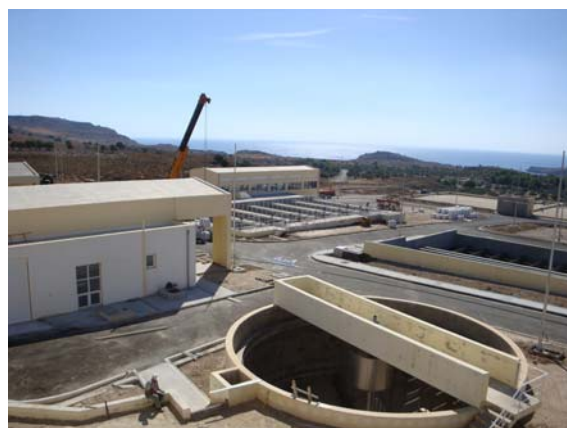
ΕΓΚΑΤΑΣΤΑΣΕΙΣ ΕΠΕΞΕΡΓΑΣΙΑΣ ΝΕΡΟΥ – ΡΟΔΟΣ ΦΑΣΗ ΚΑΤΑΣΚΕΥΗΣ
